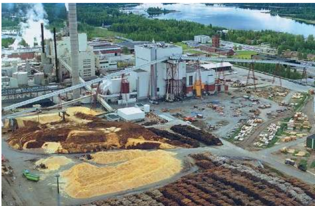
Рис. 3.7. Паливний склад ТЕЦ «Albolmens Kraft-2» (Фінляндія), що працює на відходах деревообробної промисловості
