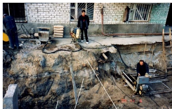
Рис. 4. Розріз основи під фундаментами будівлі та укріплення мулового шару горизонтальним армуванням
