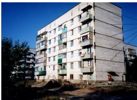
Рис. 3 Загальний вигляд формованого будинку по вул. Силікатній, 27 у м. Миколаїв
