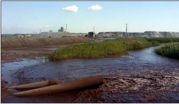
Рис. 1. Накопичення металургійних шламів в акумулюючій ємності ПАТ АМКР, розташовані в межах водозбірній площі р. Інгулець
