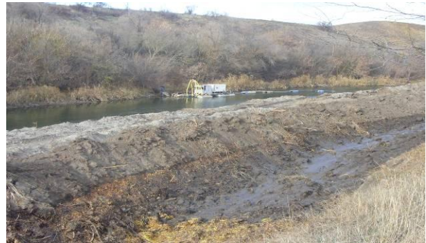
Рис 2. Дноочисні роботи на р. Інгулець з подальшим захороненням донних осадків
