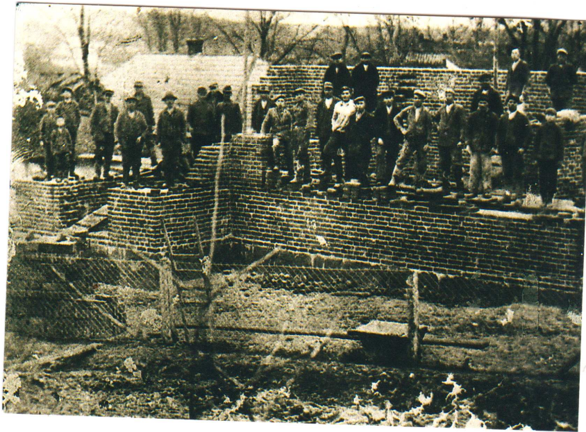
Фото 14. Будівництво кооперативи с. Крогулець (весна 1939 р.).
